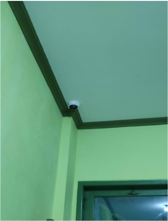
Pemasangan IP CAM Ruang SOKA 3A 2 Unit
